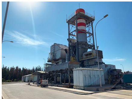
Central Colmito opera una turbina aeroderivativa Marca Rolls Royce Trent 60 WLE dual, lo cual significa que puede operar con combustible Gas o Diesel en ciclo abierto,
