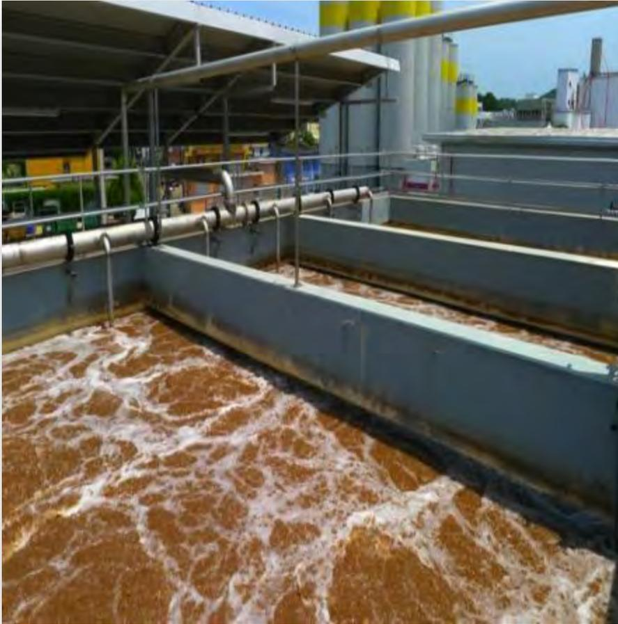
La fase de digestión aeróbica elimina un **85%** de la carga orgánica del agua
