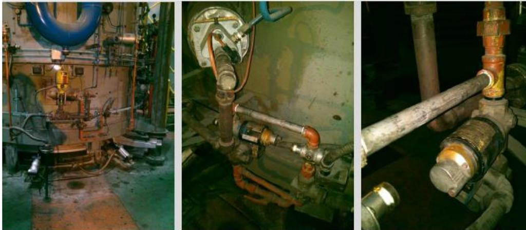
Fig. 1.10 Fotografías de la instalación ya después de la acción corregida, se hizo el cambio del tubo donde se encontraba el orificio de fuga.
