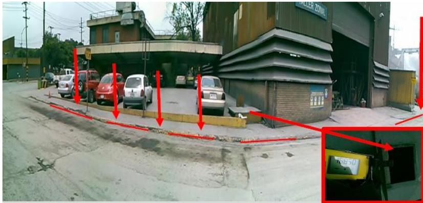
Fig. 1.7 Trayecto de la tubería e imagen de la concentración en uno de los registros de la zona.
