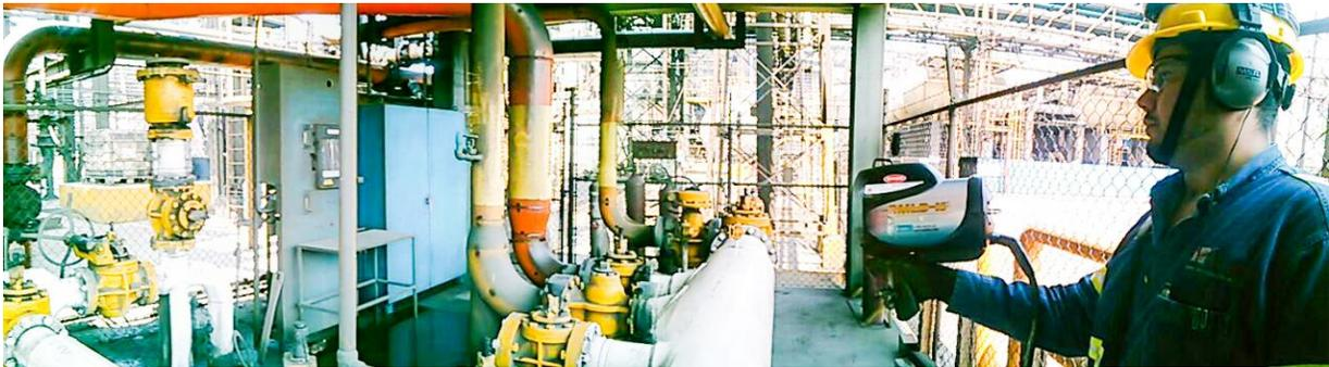
Fig. 1.2 La tecnología de Espectroscopia Láser detecta las pérdidas de gas natural de manera segura.
