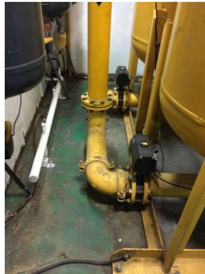
Fig. 1.22 Certificación de hermeticidad de válvulas cambiadas por una tarea de mantenimiento correctivo.
